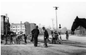
▲ Construcción de vías férreas, alrededor de principios del siglo XX.
